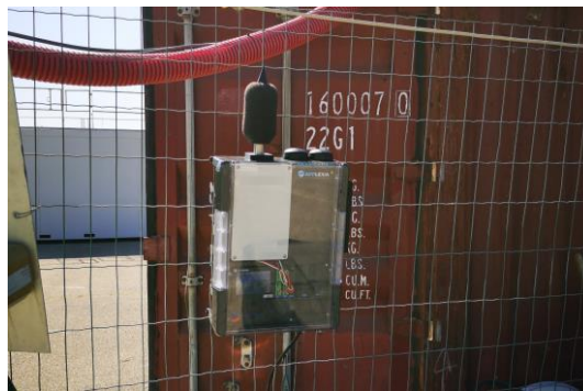
Solution déployée sur chantier
