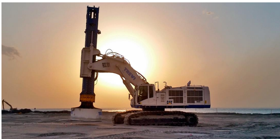
Engin de chantier RIC Menard
