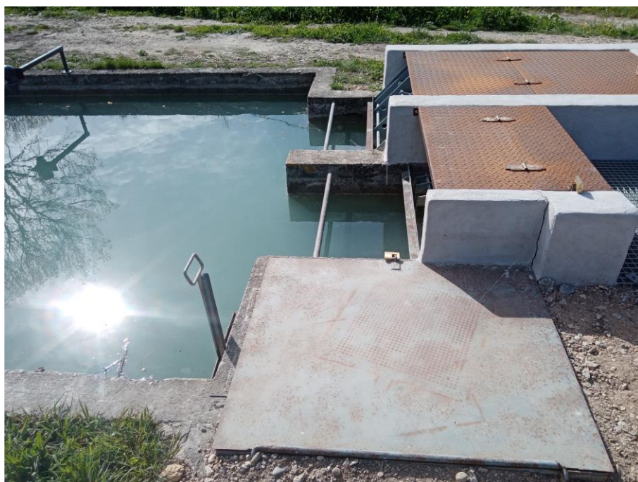
Vanne martellière automatisée et télépilotee par la solution Wixia
